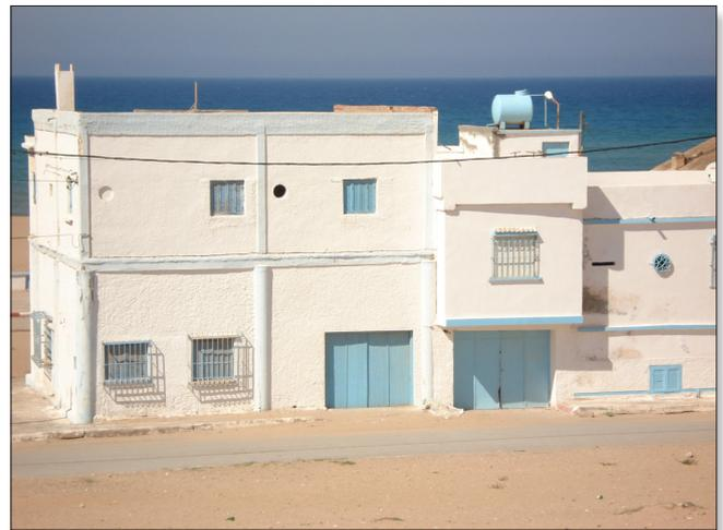
Photo 7 – Maison de plage à Terga construite à l'origine sur des pilotis pour ne pas bloquer les échanges sédimentaires et l'écoulement des eaux de surface. La construction des rez-de-chaussée des maisons est une pratique généralisée qui permet l'extension de la maison pour des raisons de location pendant l'été – Cliché Ghodbani, 2012.
